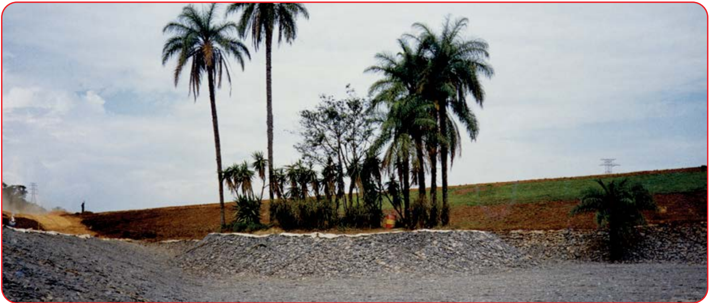
Revestimento de bacias
