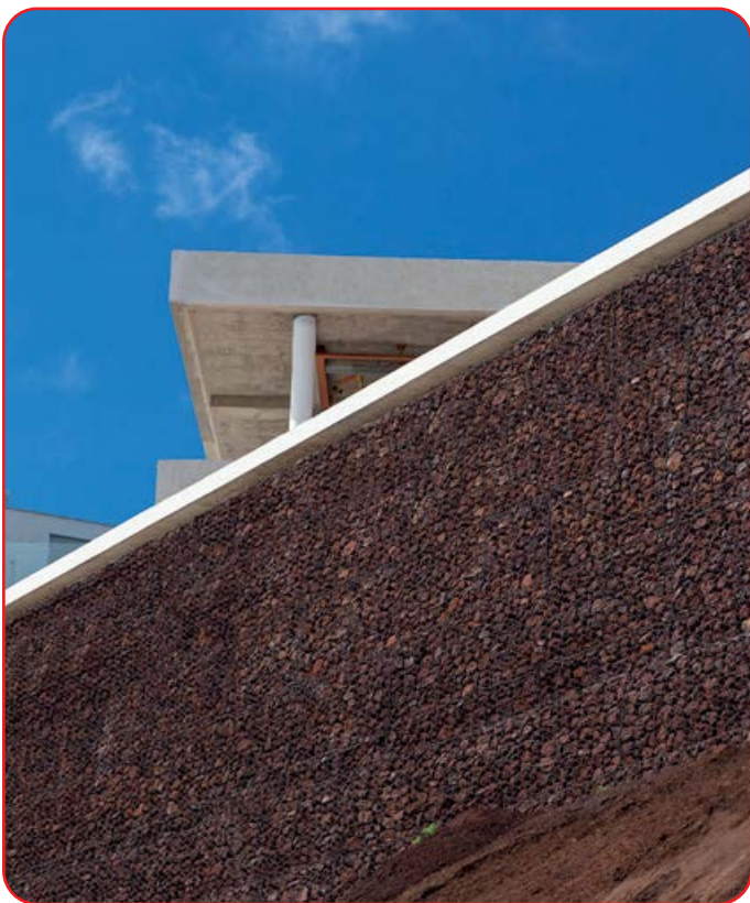
Muros de gravidade em obras prediais
