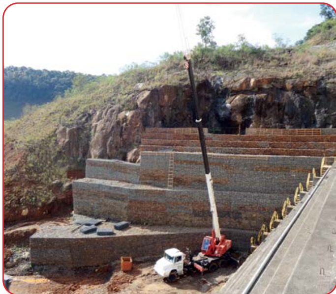
Contenção de maciços rochosos
