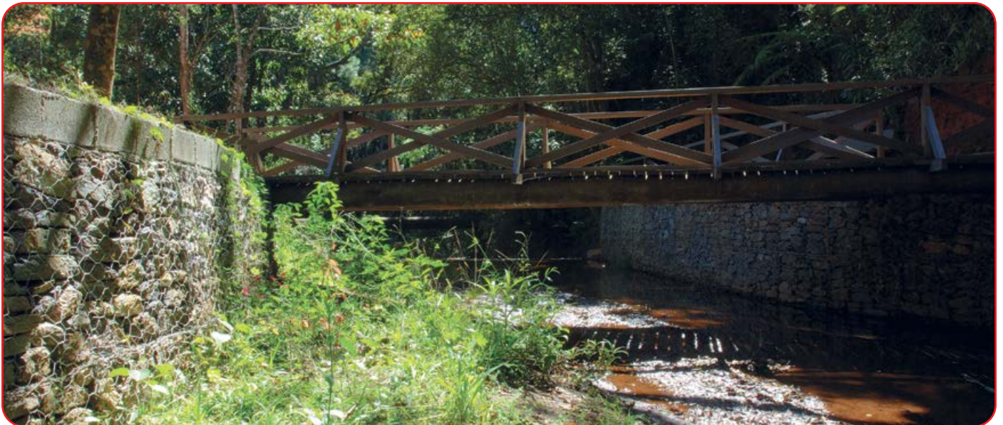
Estruturas de contenção e suporte
