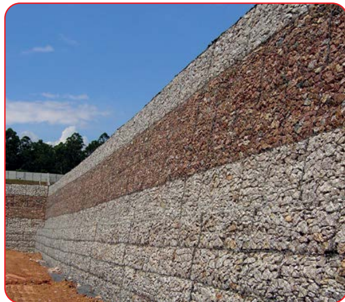
Contenção em platô de obra industrial
