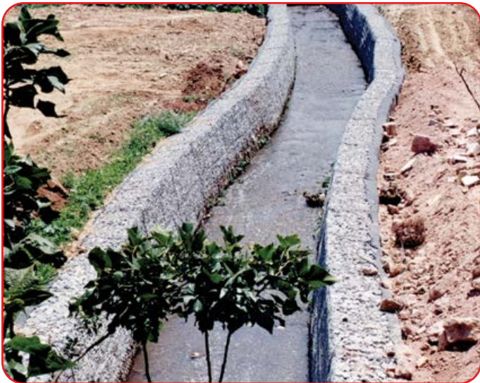
Obras de retificação de córregos e canalizações
